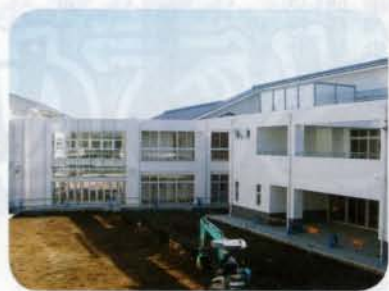
渡り廊下でつながる管理棟 (右)
