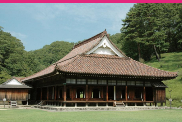
関谷学校(岡山県備前市)
