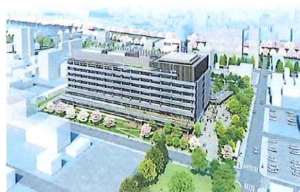
5 代目市役所（建設中）
